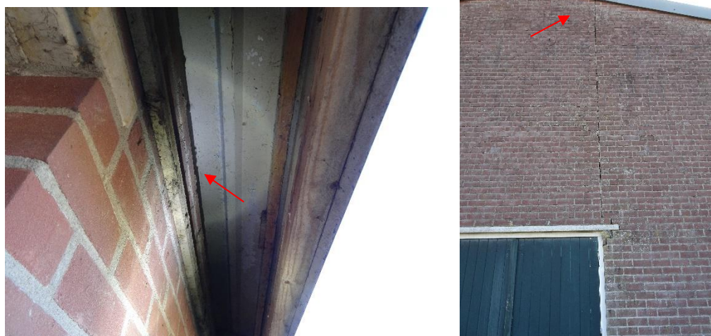
Openingen voor de vleermuis om de spouwmuur te kunnen bereiken (Foto's Laneco)
